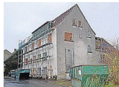
Wird abgerissen: der Wiko-Bau.
