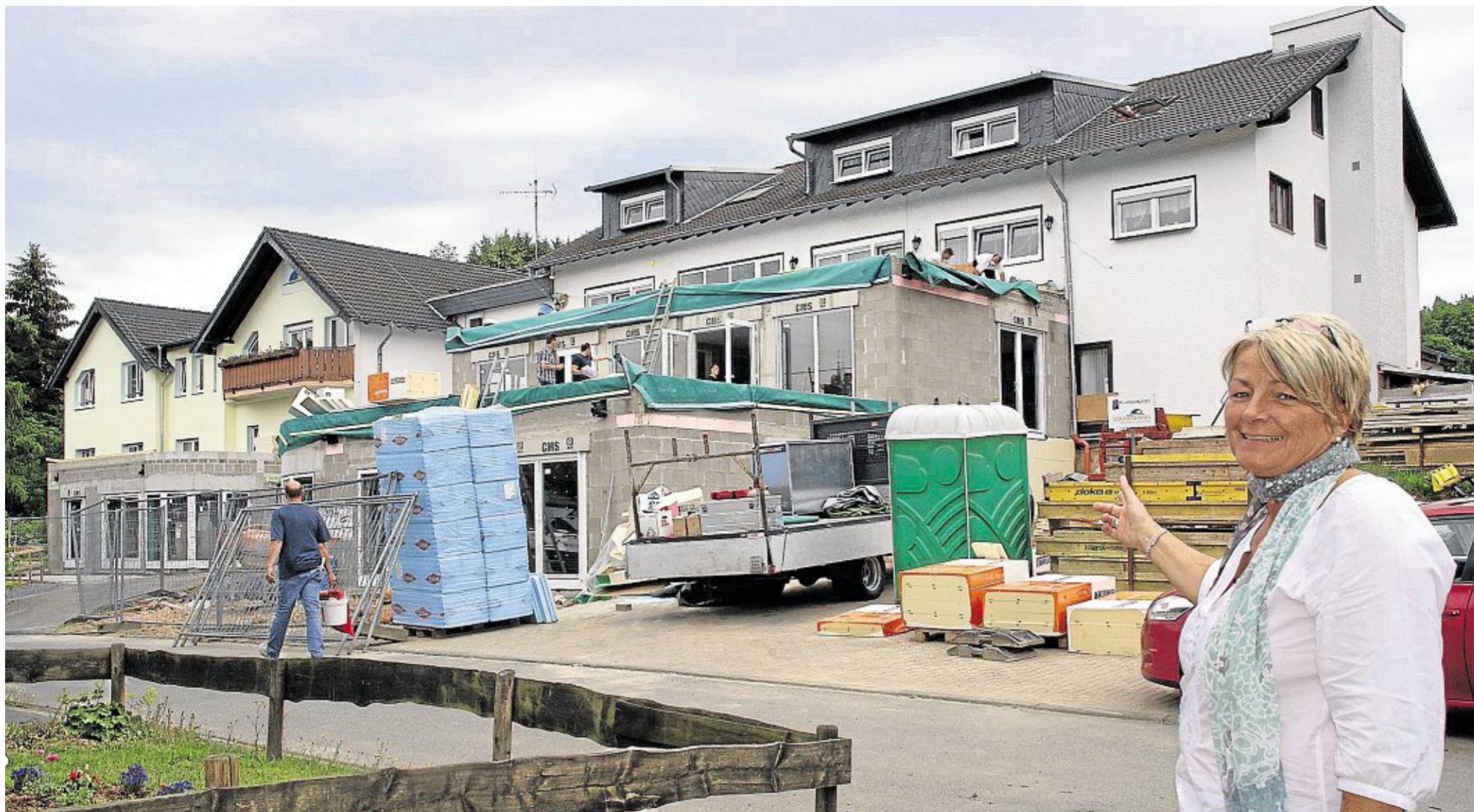
Mit einer umfangreichen Um- und Neubaumaßnahme wird zur Zeit das Seniorenpflegehaus Sonnenhang modernisiert.
