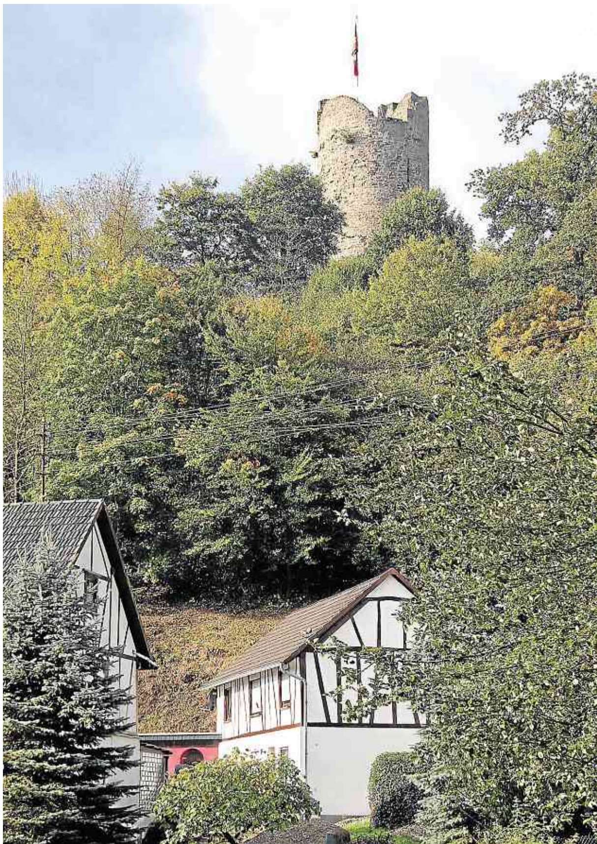
Die Ruine der Burg Lahr ist derart marode, dass die Sanierung für die Gemeinde nicht zu schultern ist.
