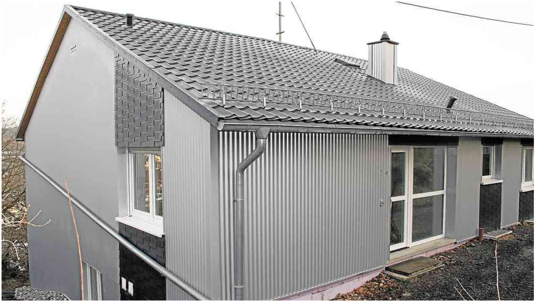
Rundum saniert präsentiert sich das etwa 30 Jahre alte Haus in der Gymnasialstraße. Fünf Mieter der Lebenshilfe sind in dieser Woche dort eingezogen.
