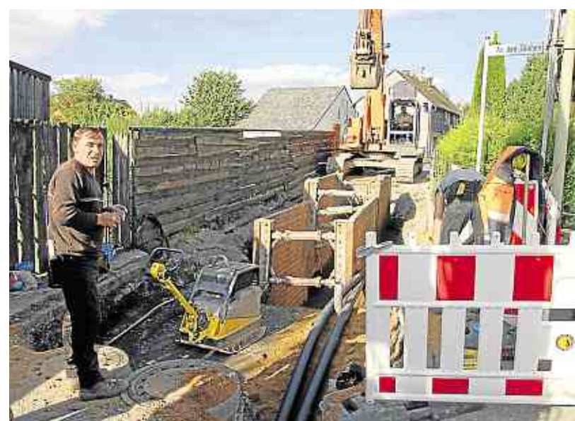
Mit dem Ausbau der Mittelstraße wurde in Breitscheid begonnen, danach erfolgt die Instandsetzung der Raiffeisenstraße. Foto: Rolf-Dieter Rötzel
