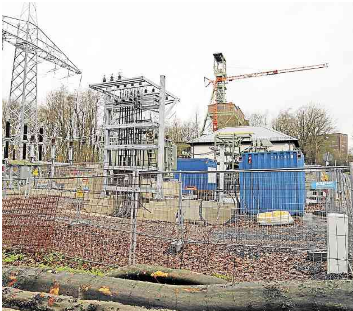
Für 1,5 Millionen Euro baut Westnetz die Umspannanlage bei Willroth um, damit dort künftig eine Spannung von 110 000 Volt transformiert werden kann. Bis Ende 2015 sollen die Arbeiten beendet sein. Foto: Heinz-Günter Augst
